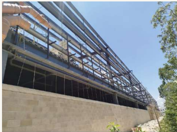
04 • Montaje de estructura metálica y cubiertas
