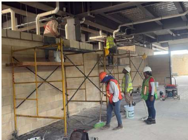
05 • Albañilería y muros divisorios
