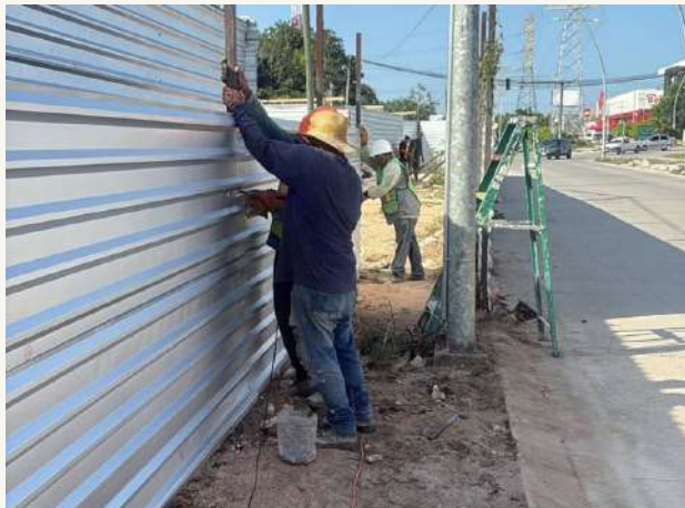
01 • Obras preliminares y confinamiento
