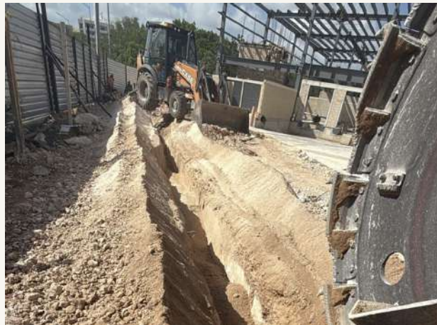
02 • Terracerías y zanjado de alta capacidad
